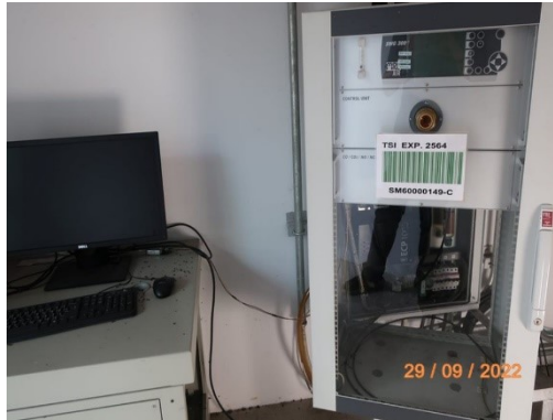
รูปที่ 1 การติดตั้ง CEMS
