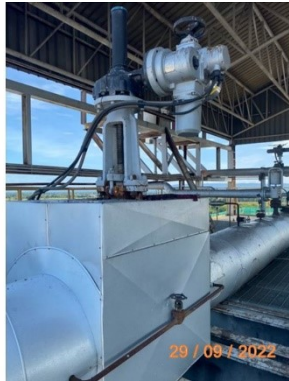
รูปที่ 42 วาล์วควบคุมความดันไอน้ำ
