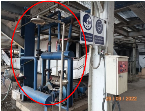
รูปที่ 35 ฝักบัวและอ่างล้างตาฉุกเฉิน
